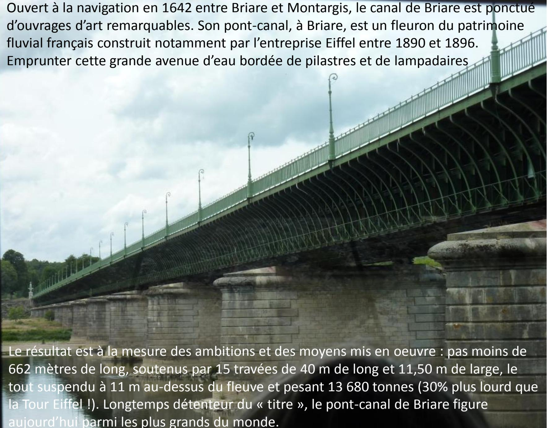
Le résultat est à la mesure des ambitions et des moyens mis en oeuvre : pas moins de 662 mètres de long, soutenus par 15 travées de 40 m de long et 11,50 m de large, le tout suspendu à 11 m au-dessus du fleuve et pesant 13 680 tonnes (30% plus lourd que la Tour Eiffel !). Longtemps détenteur du « titre », le pont-canal de Briare figure aujourd'hui parmi les plus grands du monde.
